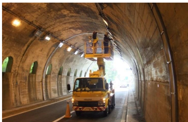
写真一解3. 1 近接目視作業状況
