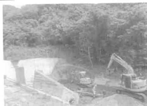
大泊地区の谷止工施工状況
