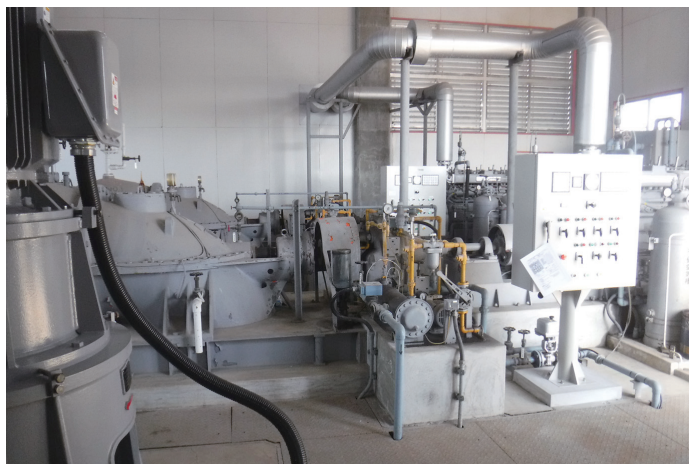
排水機場の改修(山口市:黒湯南)
