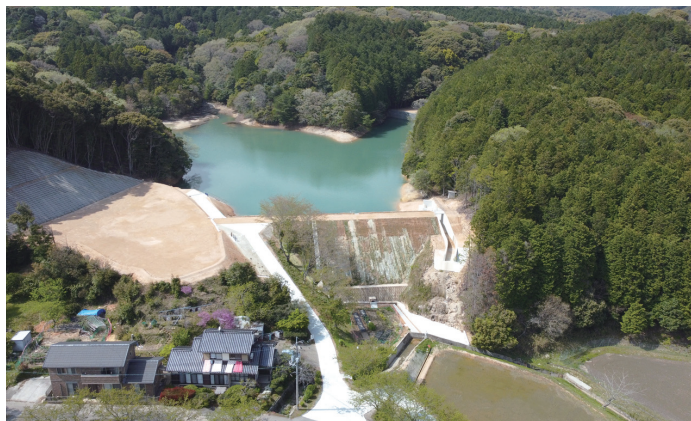
ため池の改修(下関市:石井)
