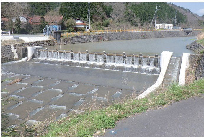
頭首工の改修(山口市:吉部野)
