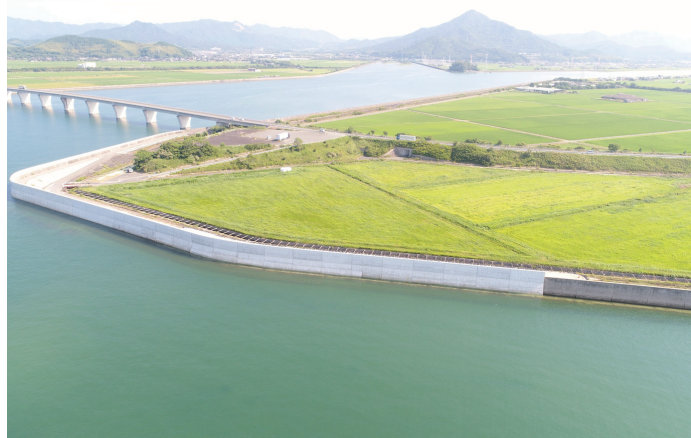
海岸堤防の補強(防府市:西之浦)
