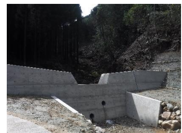
治山ダムの整備
