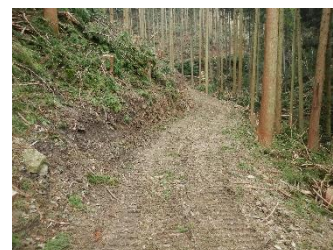
森林作業道の開設
