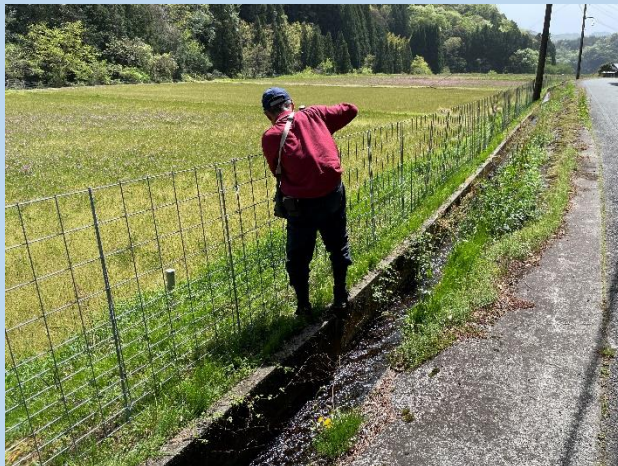
【イノシシ侵入防止柵の設置作業】
