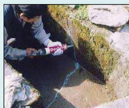
ひび割れの補修
