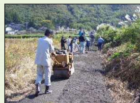
未舗装農道の舗装
