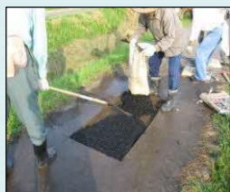
農道の部分補修
