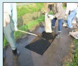
農道の部分補修
