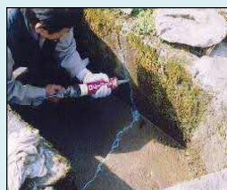
ひび割れの補修
