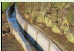
素堀り水路からの更新
