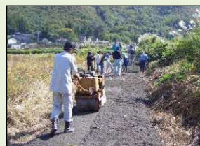
未舗装農道の舗装
