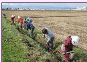
水路の泥上げ
