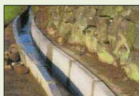
素堀り水路からの更新
