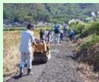
未舗装農道の舗装
