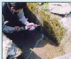
ひび割れの補修
