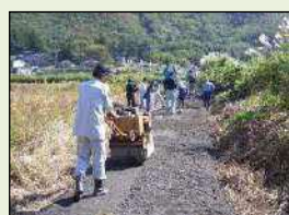
未舗装農道の舗装
