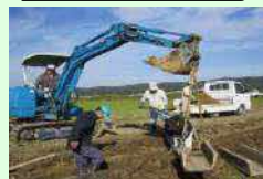
コンクリート水路の更新
