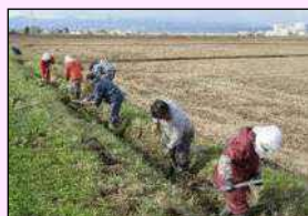
水路の泥上げ
