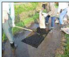
農道の部分補修
