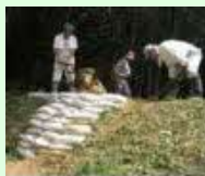
漏水箇所の補修
