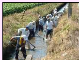
水路の泥上げ
