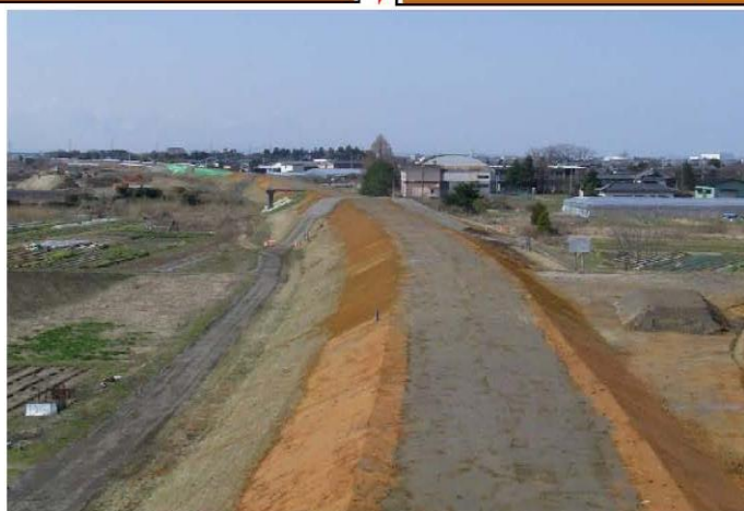
図 3.3.10 堤防のかさ上げイメージ
