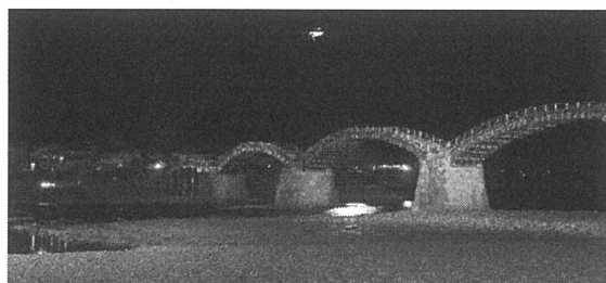
岩国市「錦帯橋」
