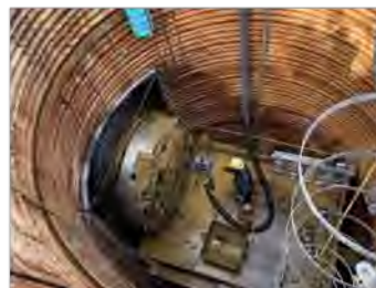
木屋川工業用水道 二条化改良工事
