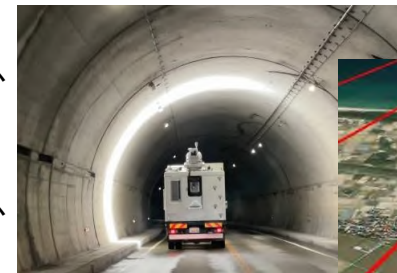
走行型 トンネル点検車
