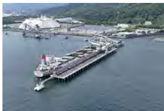
徳山下松港下松地区栈橋
