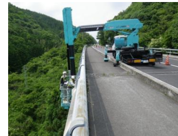
橋梁作業車を使った点検状況
