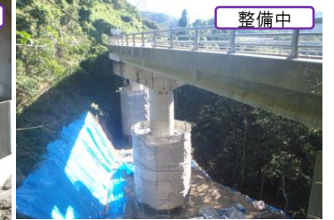
鉄筋コンクリート巻立て工法
