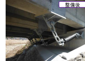
落橋防止構造
