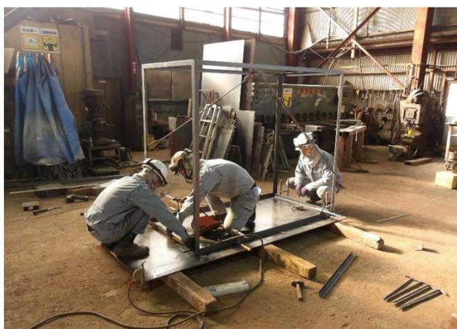
わな枠を鋼材で組立（天井面）
