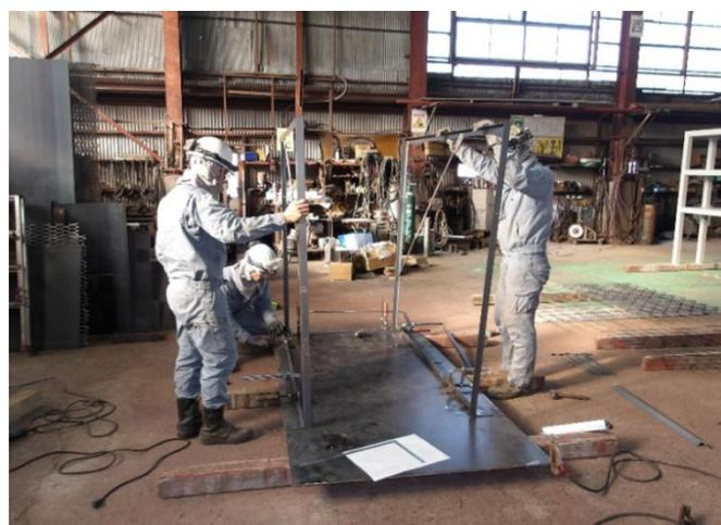
わな枠を鋼材で組立（側面）
