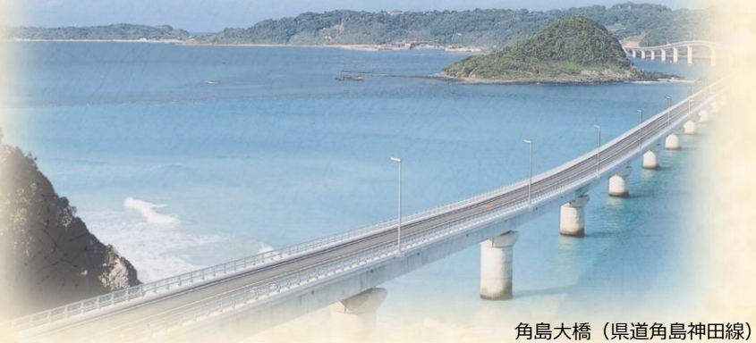
角島大橋 (県道角島神田線)
