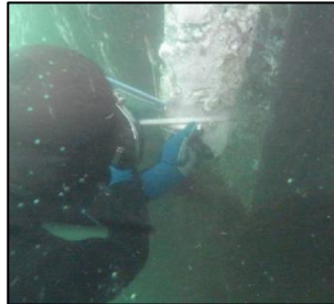
港湾岸壁点検
