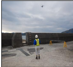
海岸護岸点検
