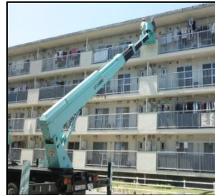
県営住宅外壁点検
