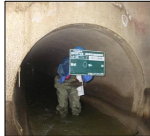
下水道函渠点検
