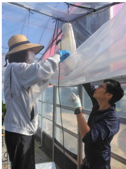
ダクト投入機器「きつつき君」設置準備
