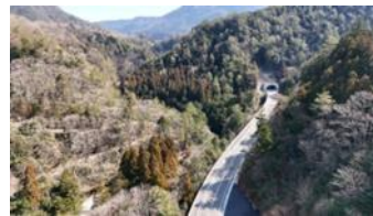
国道434号（須川バイパス）
