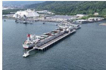
徳山下松港下松地区棧橋
