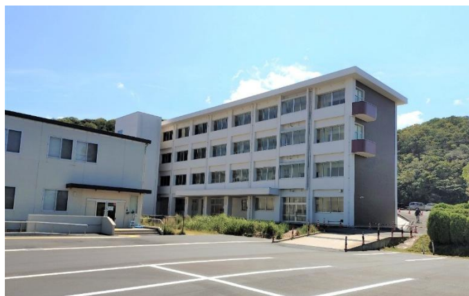
管理棟・高等部棟
