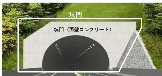
図 1-3 点検対象箇所（トンネル坑口部）
