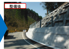
のり枠工 + 落石防護柵工
