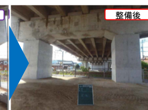
鉄筋コンクリート巻立て工法
