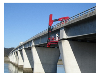
橋梁作業車を使った点検状況
