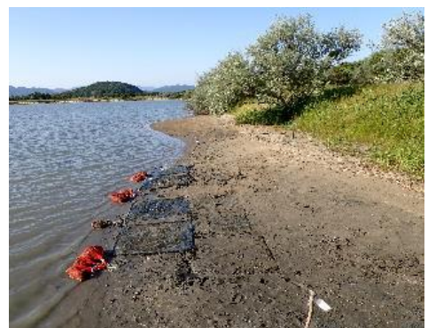
図 2-3 汽水池造成干潟と網袋、被覆網設置の様子
