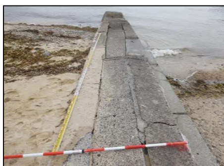
突堤(天端ひび割れ)
