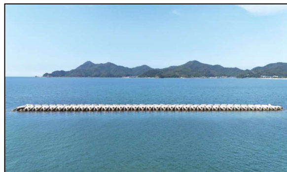
健全度 D(離岸堤) (変状が無い)
