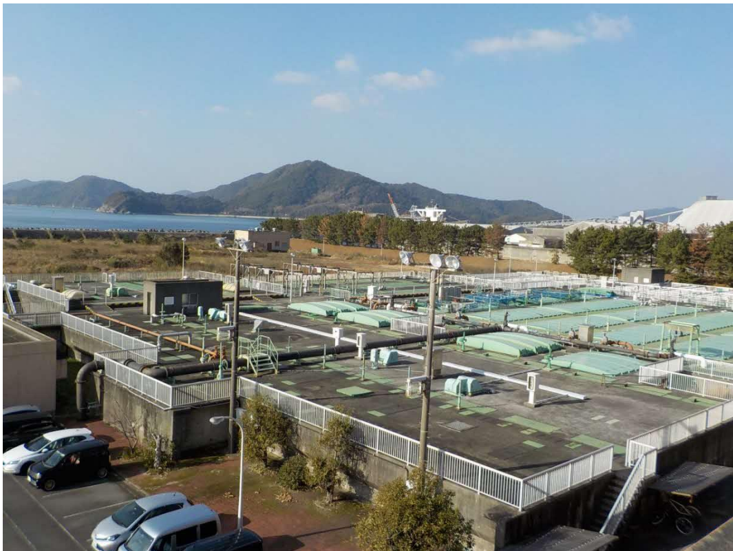
周南浄化センター全景
