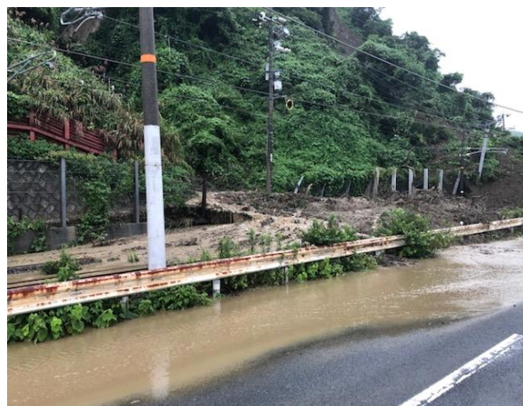
▽平成30年7月豪雨災害(線路への土砂流入)
