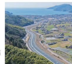
一般国道2号富海(とのみ)拡幅4車線開通(令和8年3月5日)
