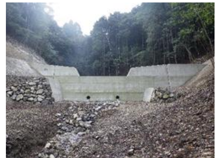
治山ダムの整備
