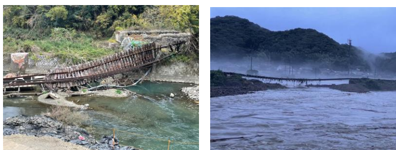
▲令和 5 年 (2023 年) の豪雨による被害状況
