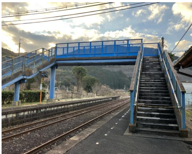
図 22 厚保駅の跨線橋
