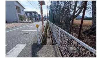
<写真撮影位置④> 北方向から市道を望む
