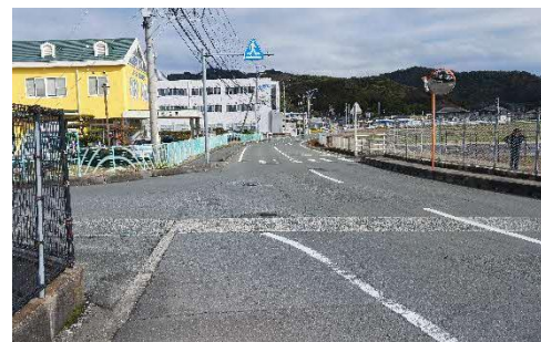
<写真撮影位置⑤> 西側市道中央地点から北方向を望む
