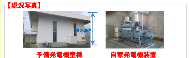
(写真: 佐波川工業用水道予備発電機室棟浸水対策事業)
