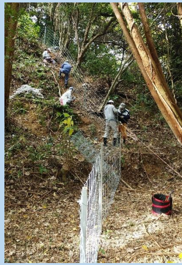
【急傾斜地での作業状況】
