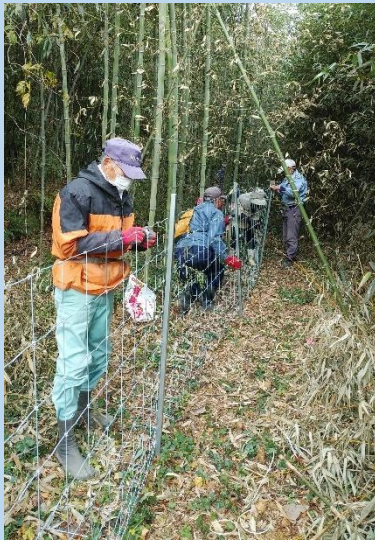
【防護柵設置状況】
