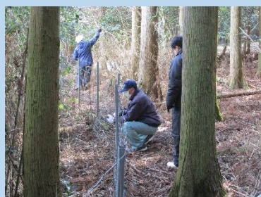
侵入防止柵の補修
