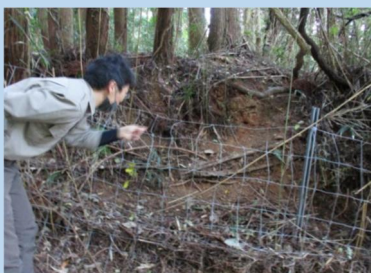
既設侵入防止柵の点検
