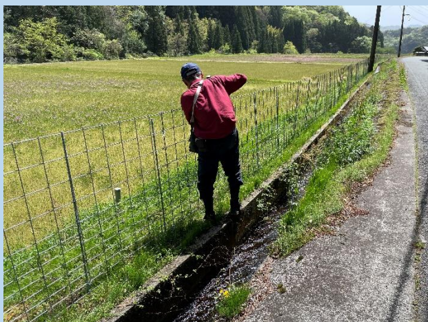
【イノシシ侵入防止柵の設置作業】
