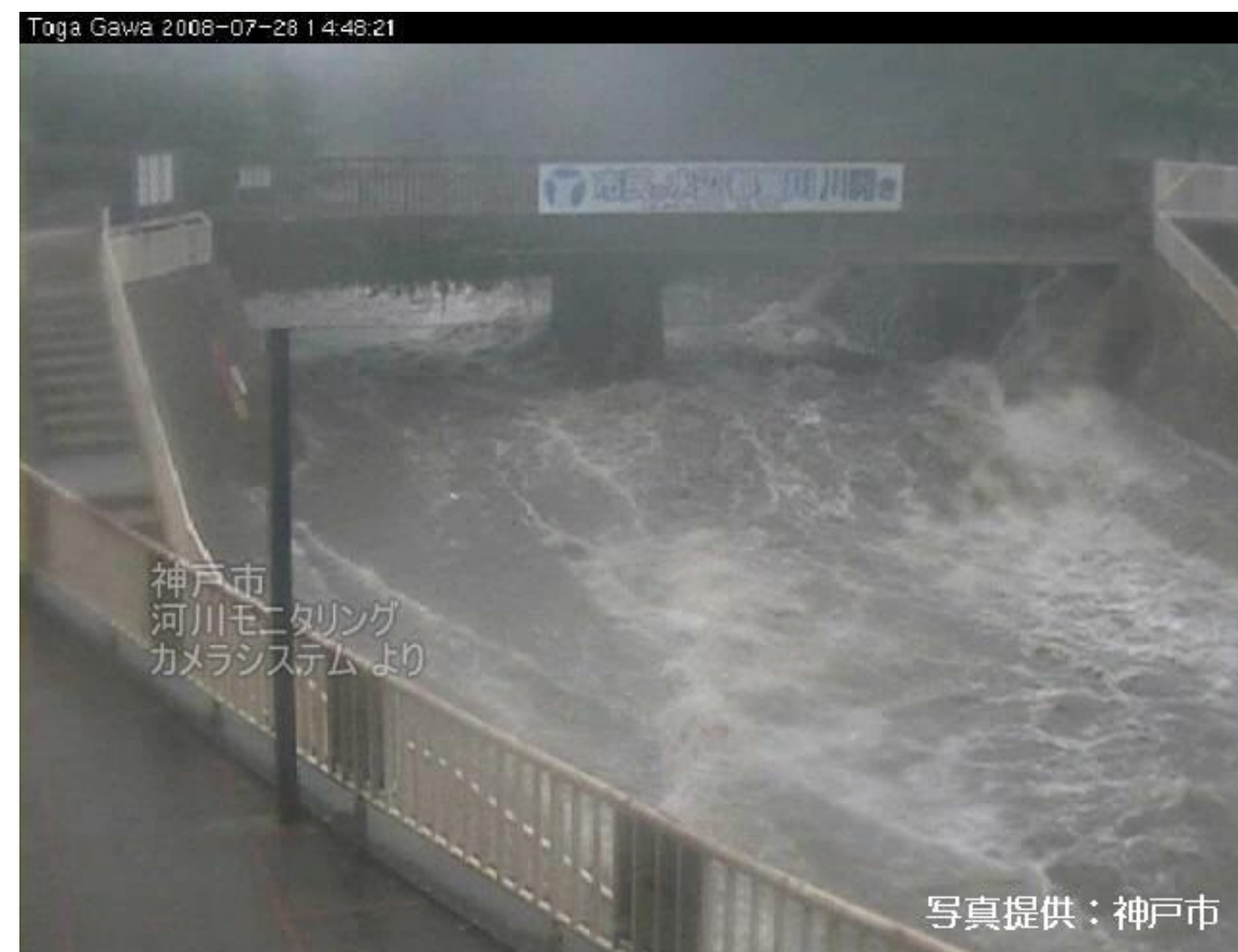
増水時の都賀川 (写真提供：神戸市)
