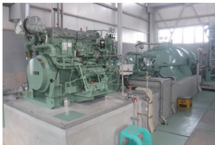
排水機場の整備(山口市:小郡開作)
