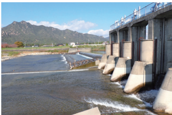
頭首工の整備(防府市:防府総合堰)
