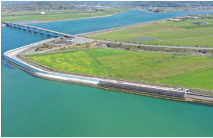
海岸堤防の補強(防府市:西之浦)
