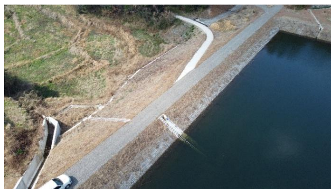
ため池の改修（泉3ため池）
