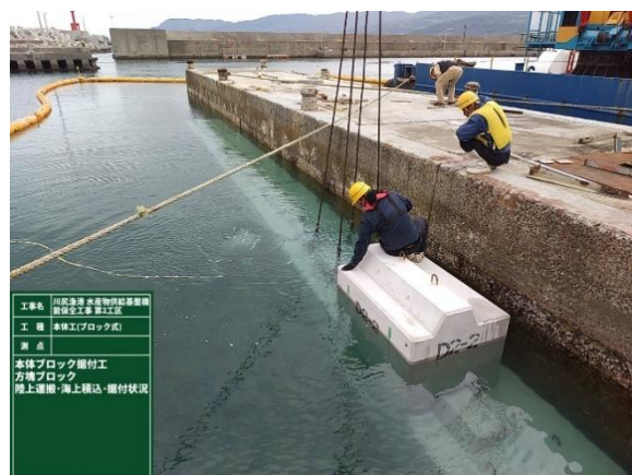
川尻漁港防波堤補修
