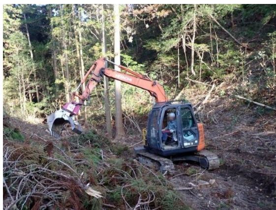
高性能林業機械による機械地拵えの実践
