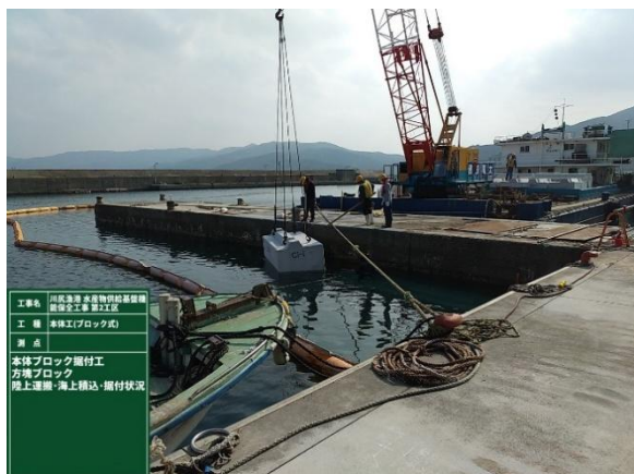
川尻漁港防波堤補修
