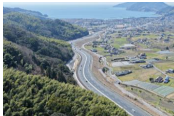
国道2号富海拡幅
