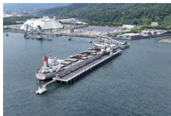
徳山下松港下松地区栈橋
