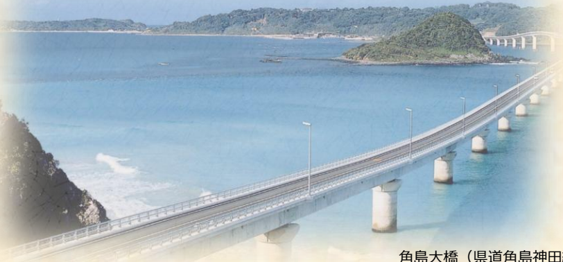
角島大橋（県道角島神田線）
