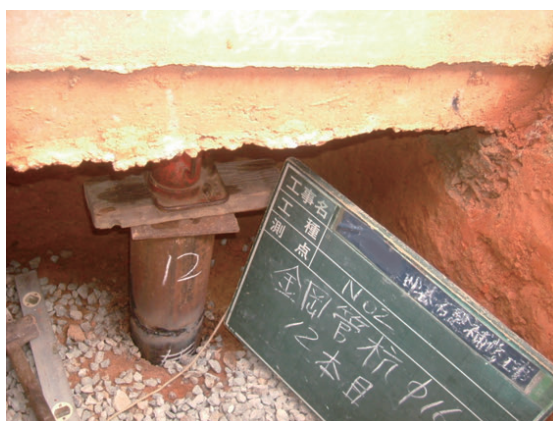
鋼管杭の圧入
