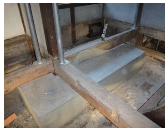
基礎を新たに施工
