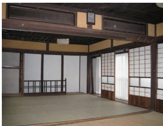
着工前：柱・壁が少ない大空間
