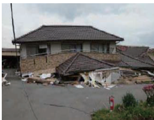
熊本地震で倒壊した木造住宅
