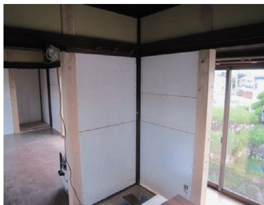
柱と壁を新たに施工
