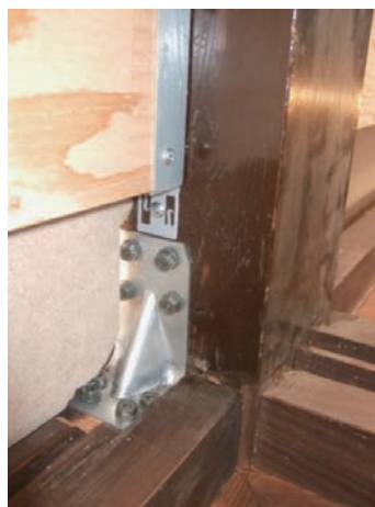
柱脚金物を取り付けた後
