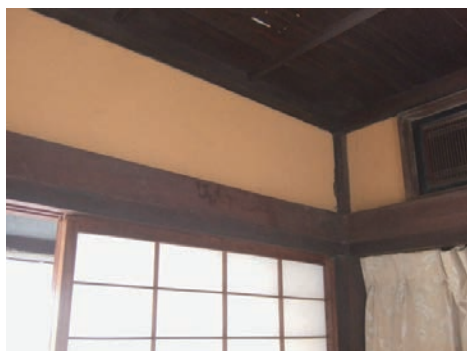
柱頭金物を取り付ける前
