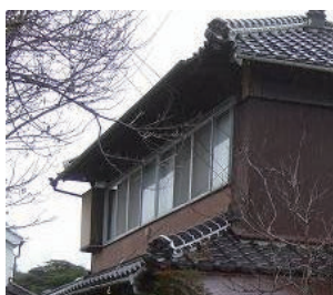
外壁材・アルミサッシ取替え
