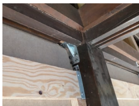
柱頭金物を取り付けた後
