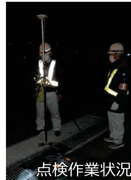
点検作業状況
