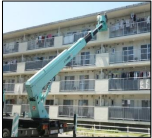
県営住宅外壁点検
