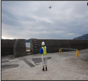
海岸護岸点検
