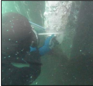
港湾岸壁点検
