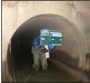
下水道函渠点検
