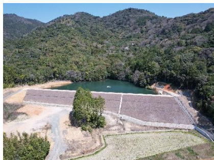
ため池の改修 (山口市：正元田ため池)
