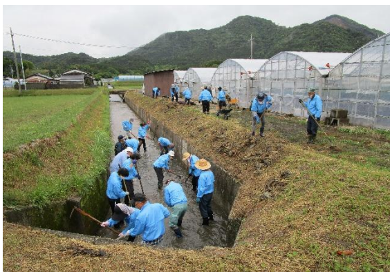
水路の維持管理作業 (多面的機能支払：防府市)
