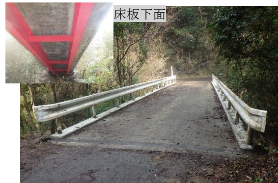
林道橋の補修（周南市：押谷線）
