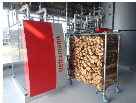
薪ボイラーの整備（阿武町）
