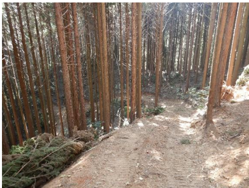
森林作業道の整備（下関市）
