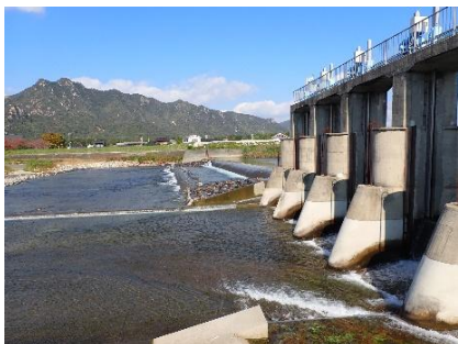
頭首工の改修 (防府市：防府総合堰)
