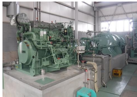
排水機場の整備 (山口市：小郡開作地区)
