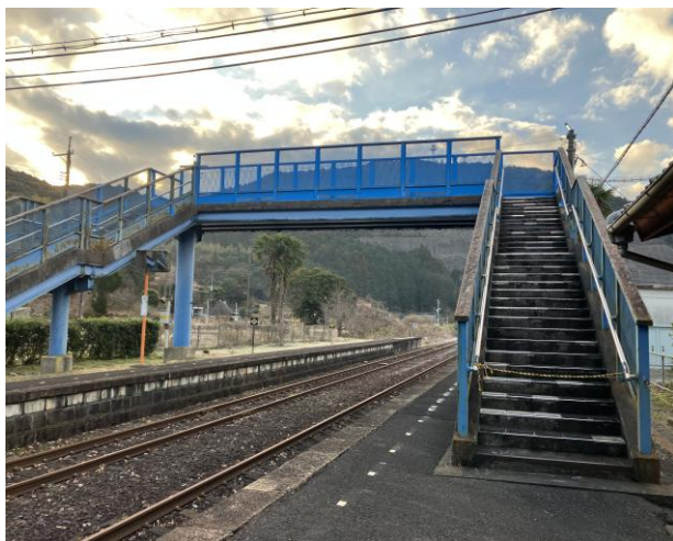
図 22 厚保駅の跨線橋
