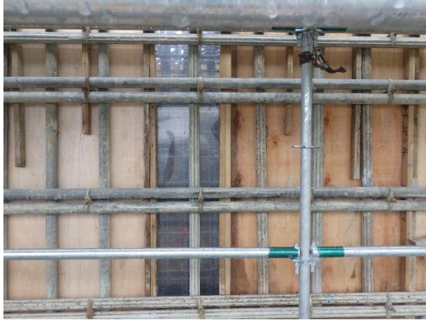
アクリル板型枠
