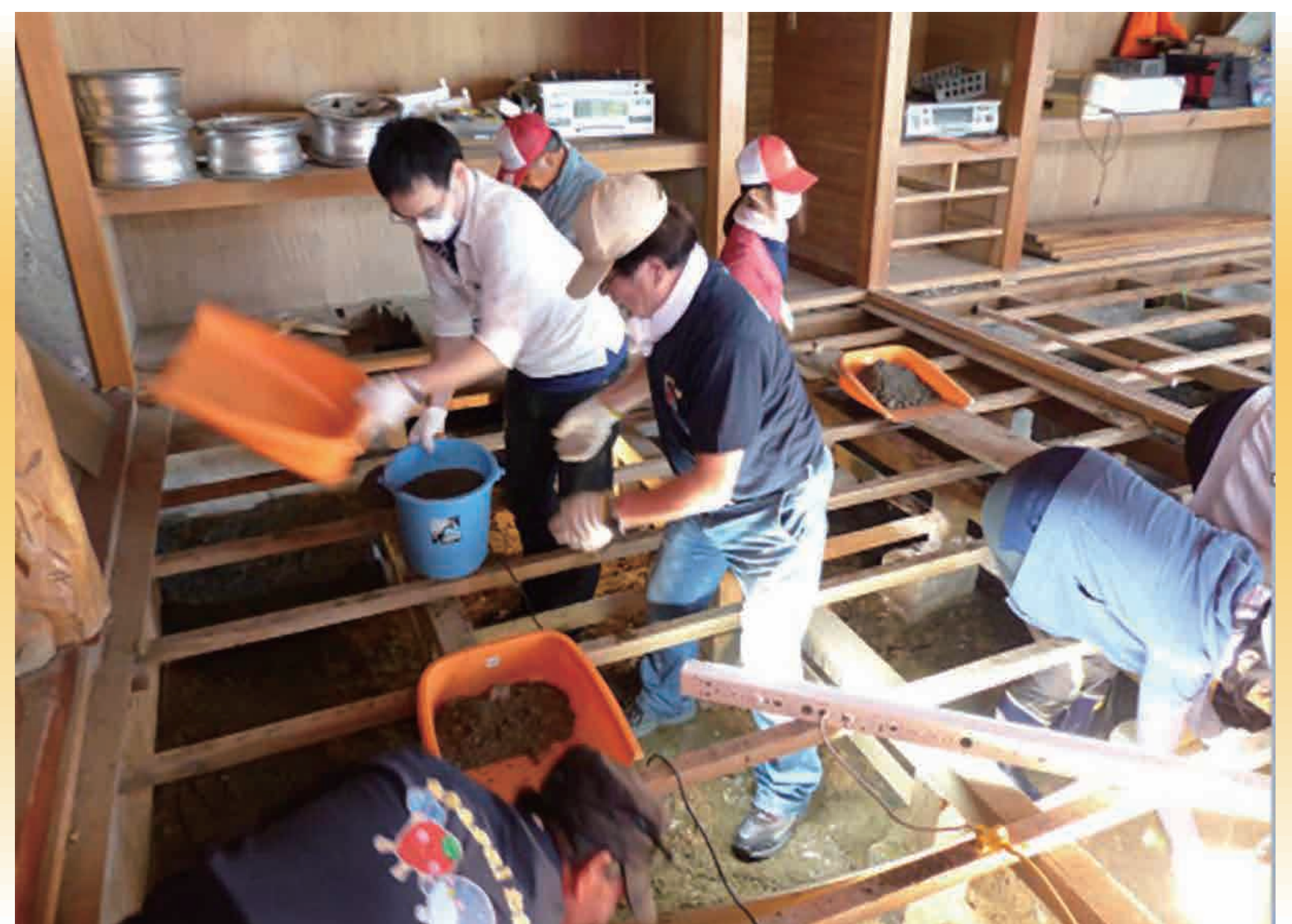
宮城県亘理町にて泥出し作業中
