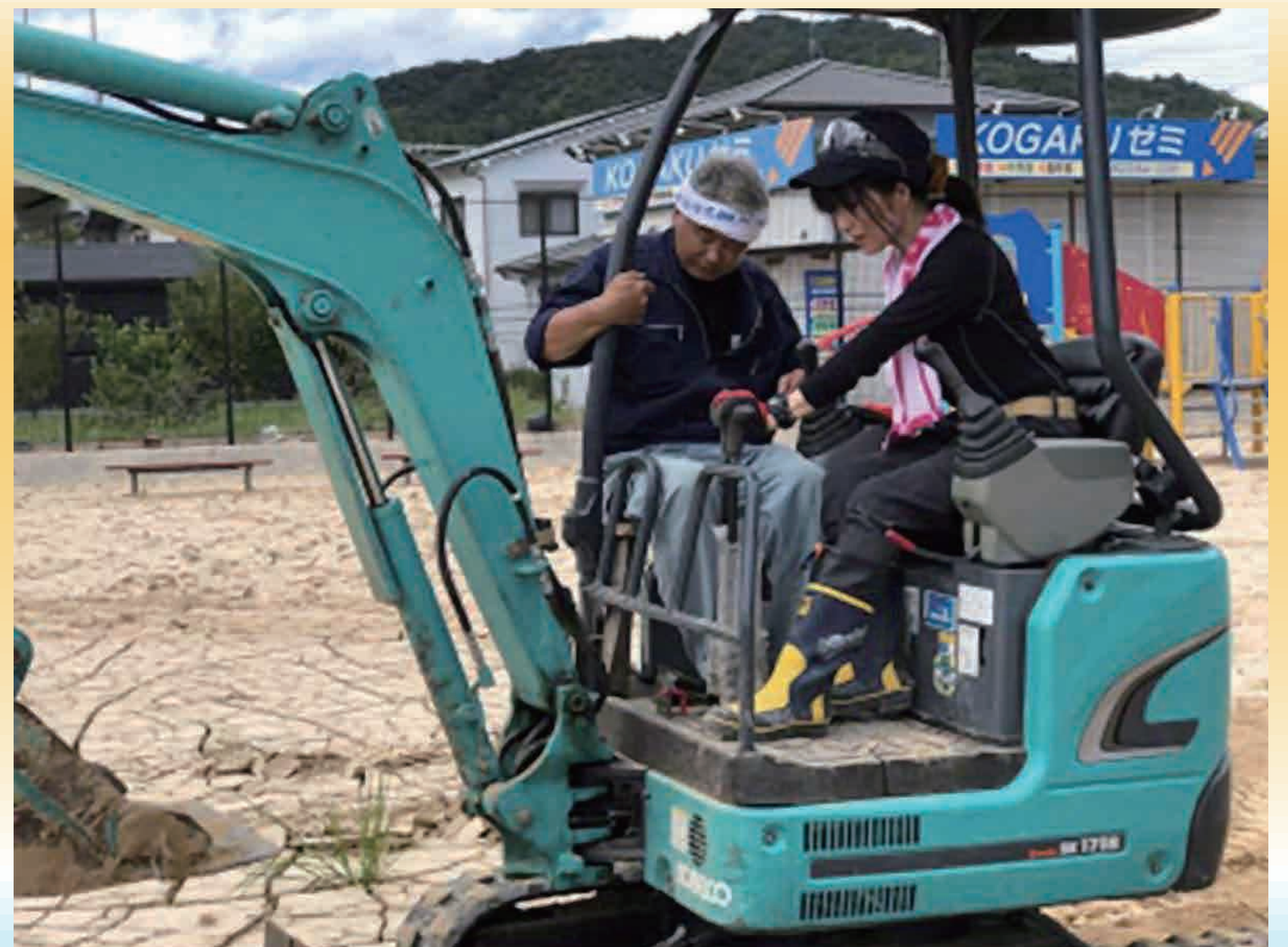
重機の実技指導中
