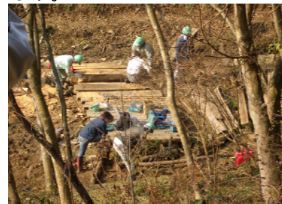
【ウッドデッキづくり】
