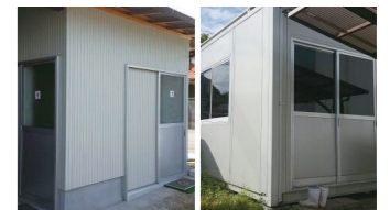
新たに増設したトイレと休憩室
