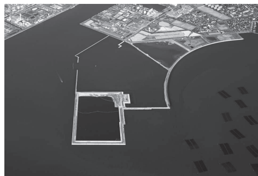
宇部港東見初広域最終処分場
