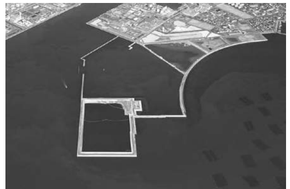
宇部市東見初地区広域最終処分場
