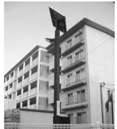
ソーラー外灯（東岐波団地）
