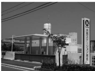
水素ステーションの整備
