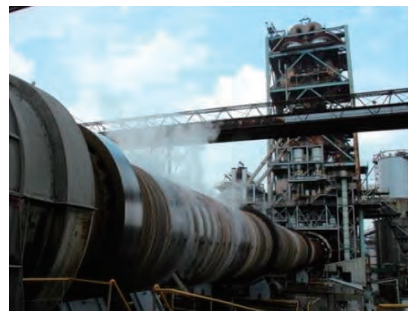
セメントプラント
